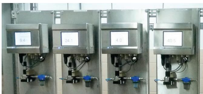
Capteurs d'oxygène montés sur un panneau dans le cycle eau-vapeur
