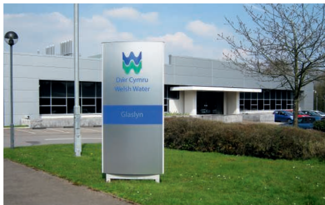
Das Dŵr Cymru (Welsh Water) Prüflabor in Glaslyn
