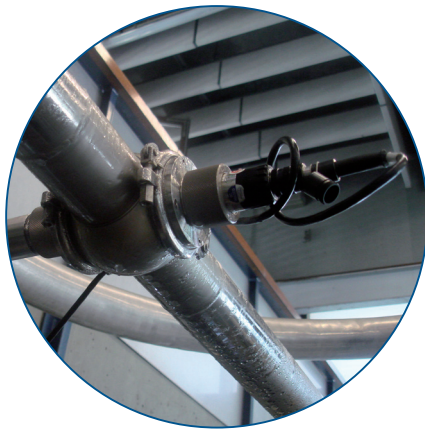
Abb. 1: M1100 Sensor im Einsatz zwischen Puffertank und Füller in einer DN60-Leitung.
