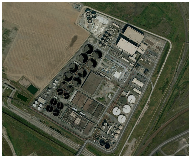
Abb. 1: Kläranlage Bran Sands
